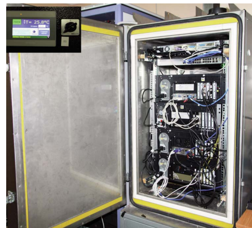
В этой термокамере проходят испытания все основные элементы аппаратного обеспечения ОСМТ «ОМЕГА»
