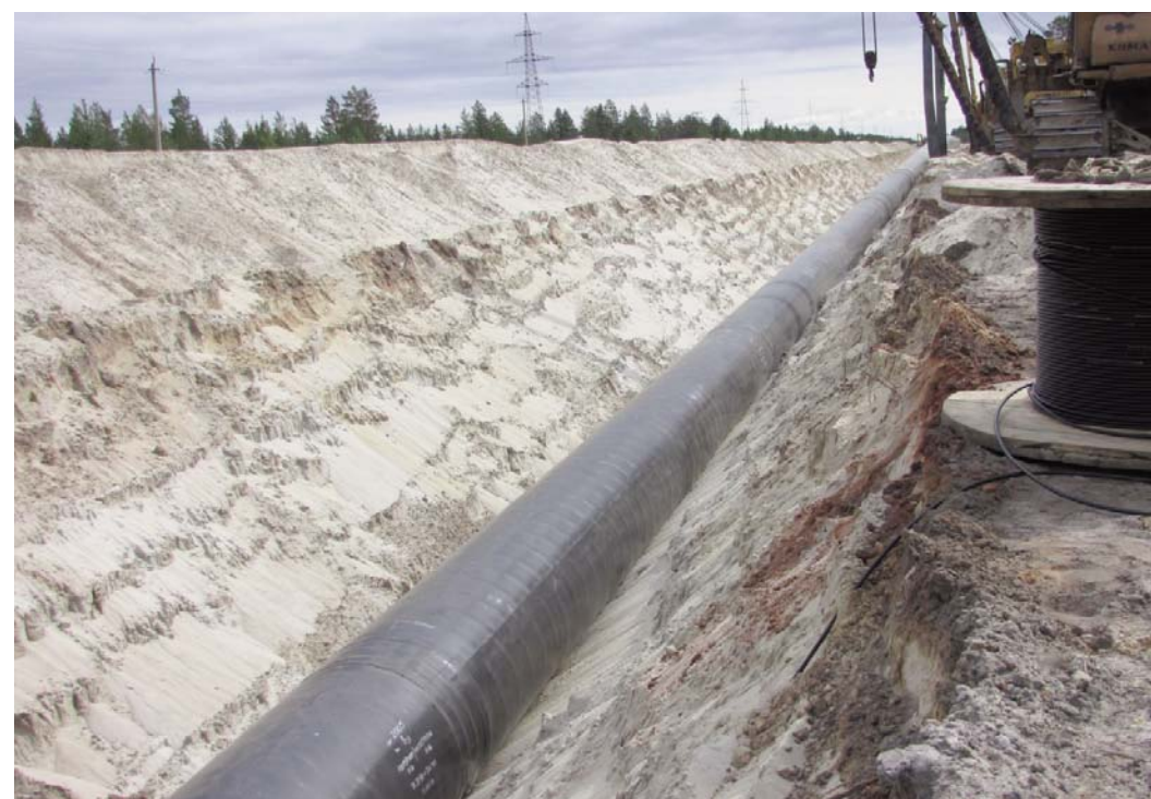
Прокладка кабеля-датчика СОУИКА «ОМЕГА» на трубопроводном объекте
